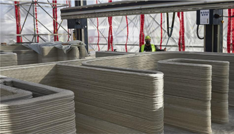
Tiempo de impresión en lugar de tiempo de construcción, equipos de dos personas en vez de una cuadrilla de obreros, capas de hormigón que brotan de una bomba de inyección gigante en vez de la colocación de piedra sobre piedra o ladrillo sobre ladrillo: la tecnología para construir casas con una impresora 3D aún está pañales, pero muchos ven en ella un enorme potencial para la construcción de viviendas y la reconstrucción en caso de una
